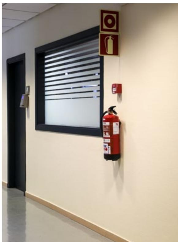
*Ejemplo de señalización de un extintor y un pulsador de alarma manual, en una vía de evacuación*
